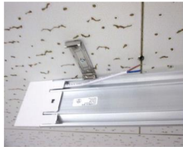
③ 電源コード圧着接続
