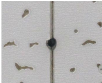
① 電源用に天井を開口
